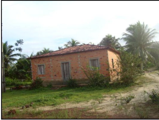
Foto 6: Fachada - casa de alvenaria na comunidade Nossa Senhora de Lourdes (a). Fonte: Pesquisa de campo, 2010.
