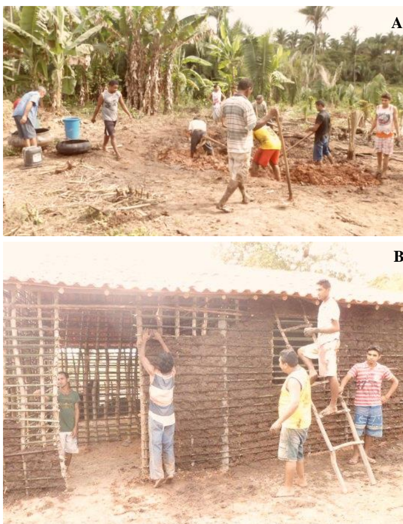
Fotografia 14 (A e B) – Homens trabalhando em mutirão no barreamento de casa de taipa para o senhor Antônio Carlos, realizada no povoado Centro dos Pernambuco, comunidade vizinha a São Manoel
